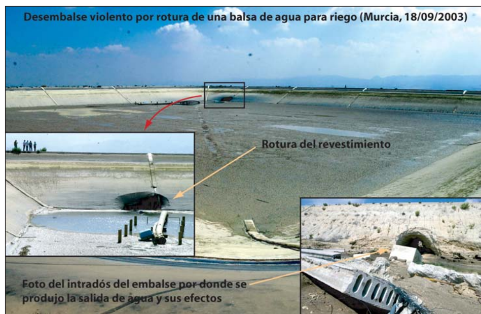
[Foto 1] Rotura de un gran embalse para agua de riego (Fotos cortesía de Vicente Vicens).
